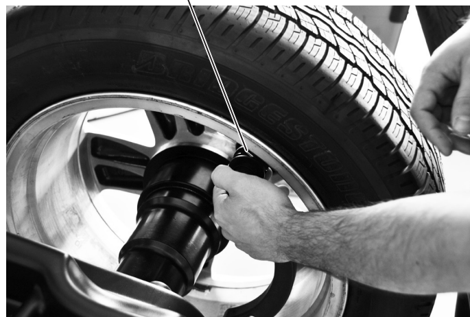
Aplicar el peso en la posición en la cual la pinza toca la rueda
